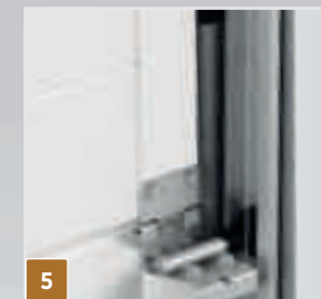
Système de ressorts de traction
