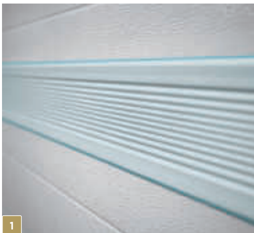
Protections flexibles entre les panneaux
