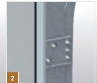
Eingeschraubte Führungsschienen mit Zarge
