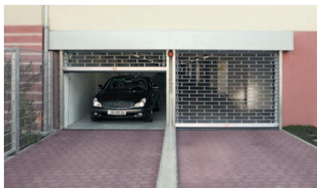
Objekt: Tiefgarage Rastatt
